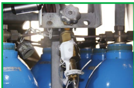
Comprobación de uniones roscadas
